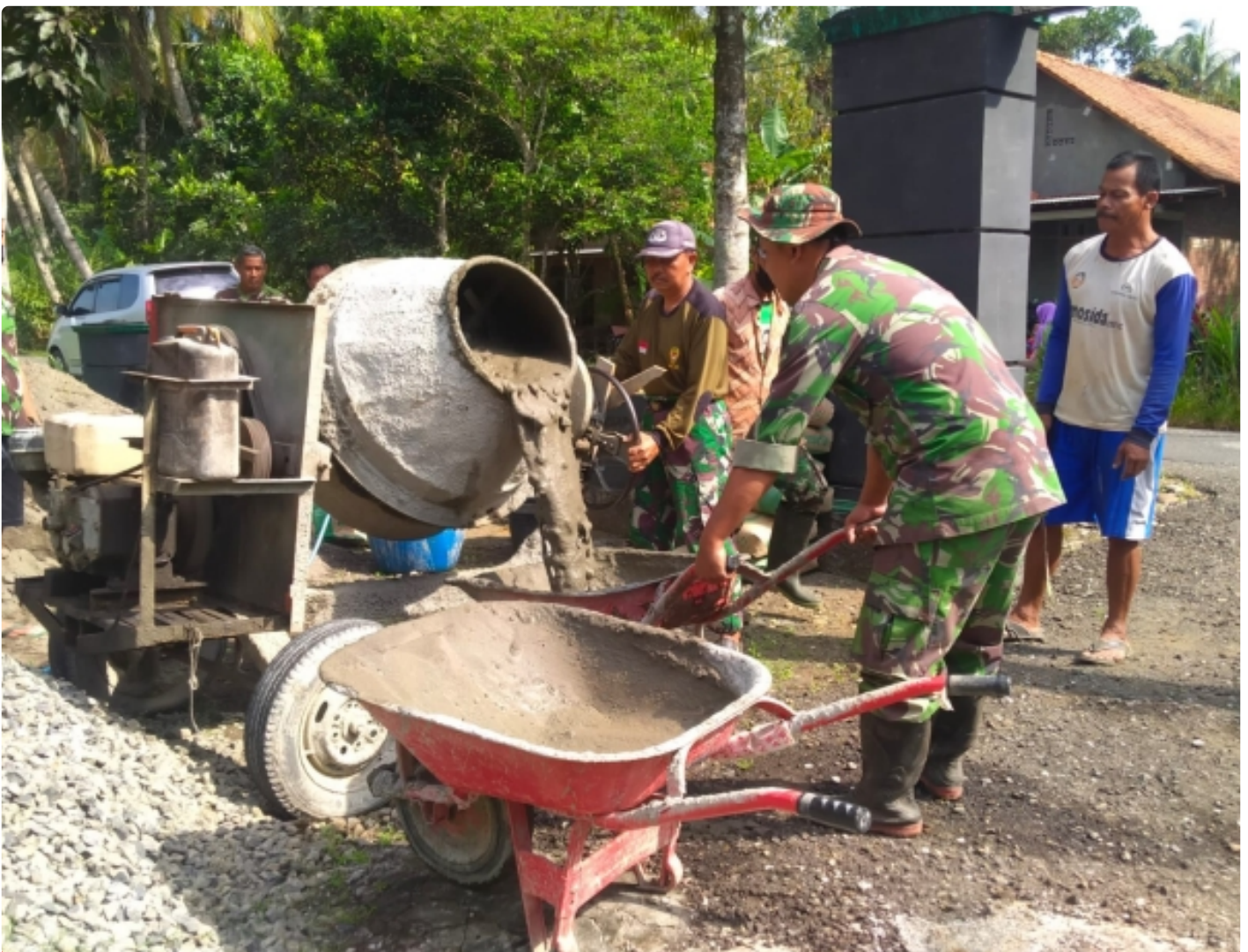
Anggota Posramil Bonorowo Bantu Warga Pengecoran Jalan
